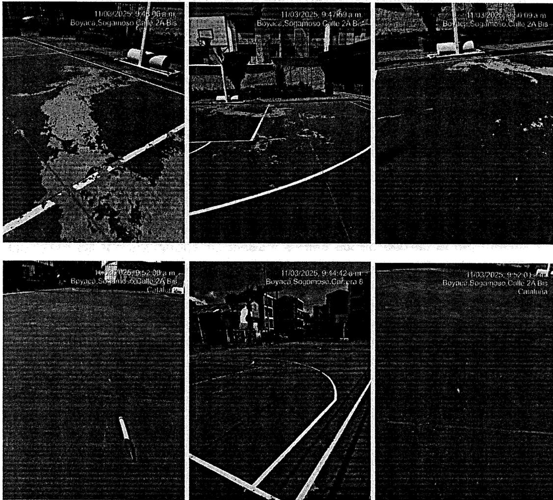
FOTOGRAFÍAS 19, 20, 21: ESTADO ACTUAL RENOVACIÓN Y MEJORA DE LAS INFRAESTRUCTURAS DEPORTIVAS Y RECREATIVAS UBICADAS EN EL BARRIO CATALUÑA, SE OBSERVA PREMATURO DETERIORO EN PINTURA CANCHA Y FISURAS EN PLACA DE CONCRETO QUE AFECTA LA ESTRUCTURA Y LA EXPONE A CONDICIONES AMBIENTALES (AGUA LLUVIA, HUMEDAD, ETC) (FOTOGRAFÍAS VISITA DE FISCALIZACIÓN)
